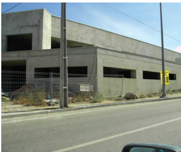
Construção do lar de Pavia
